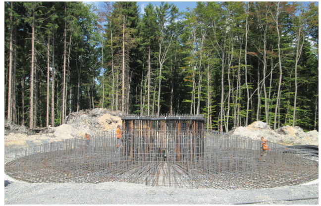
Abbildung 3: Bau des Fundaments einer Windenergieanlage in einem südhessischen Waldgebiet (Quelle: BDL Baudienstleistungen Untermain GmbH)
